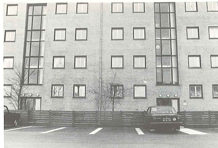
... ud mod den støjende gennemfartsvej.
